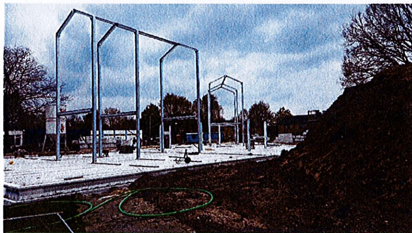
CBS Het Mozaïek in aanbouw (mei 2017)
